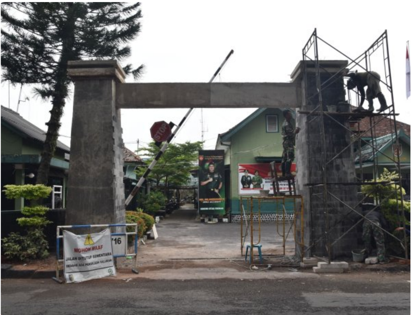
Personel Kodim 0716/Demak yang dipimpin Kapok Tuud Peltu Satir melaksanakan pembangunan Gapura pintu gerbang
