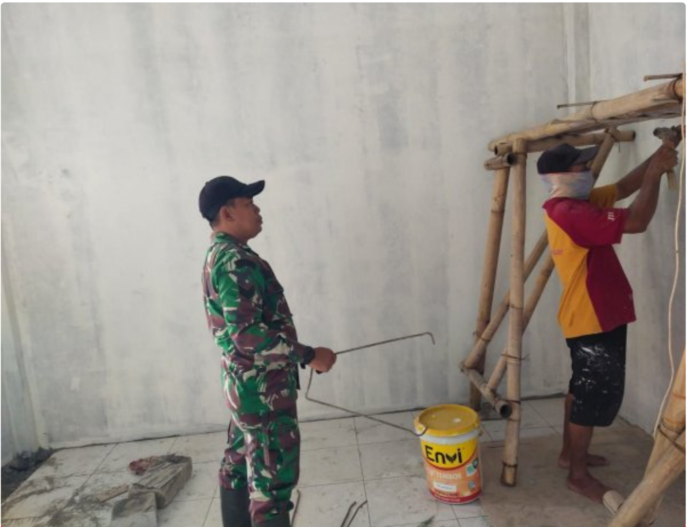
Babinsa Jatirogo Awasi Pemasangan Instalsis Listrik Di KDKMP
